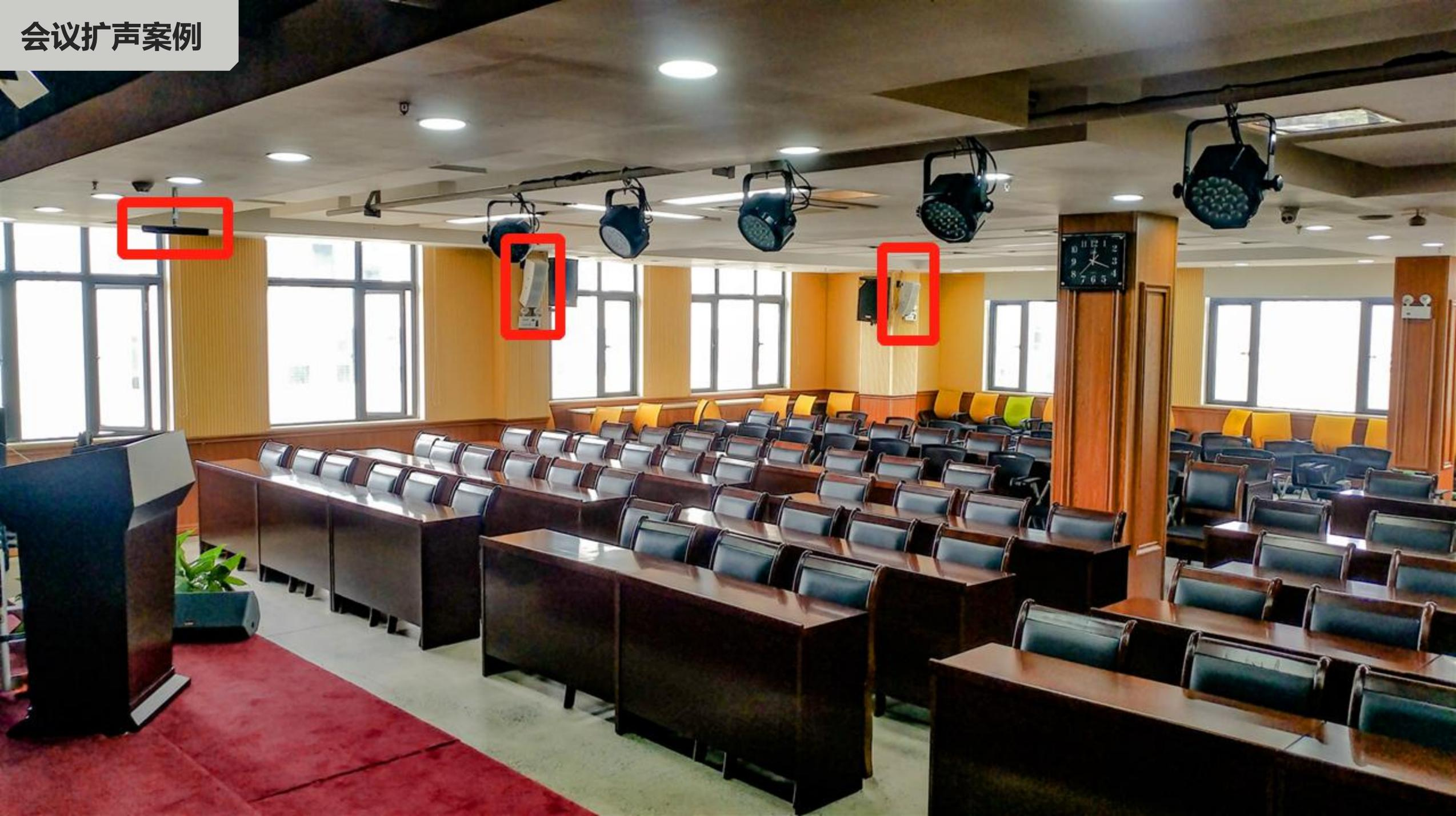
安装前先将**支架母件**安装在音箱背面（如音箱图），**支架公件**利用**8mm**的膨胀螺丝固定在墙上（如支架图），支架底部距离地面**2.5-2.8米**为宜。（每个支架都配有**8mm**膨胀螺丝）
