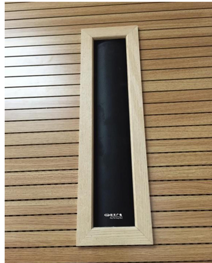
音箱嵌墙安装示意图
