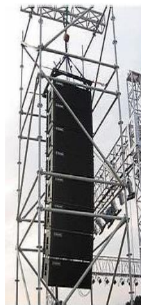
线阵音箱户外安装
