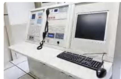
第三方对接 (消防/监控)
