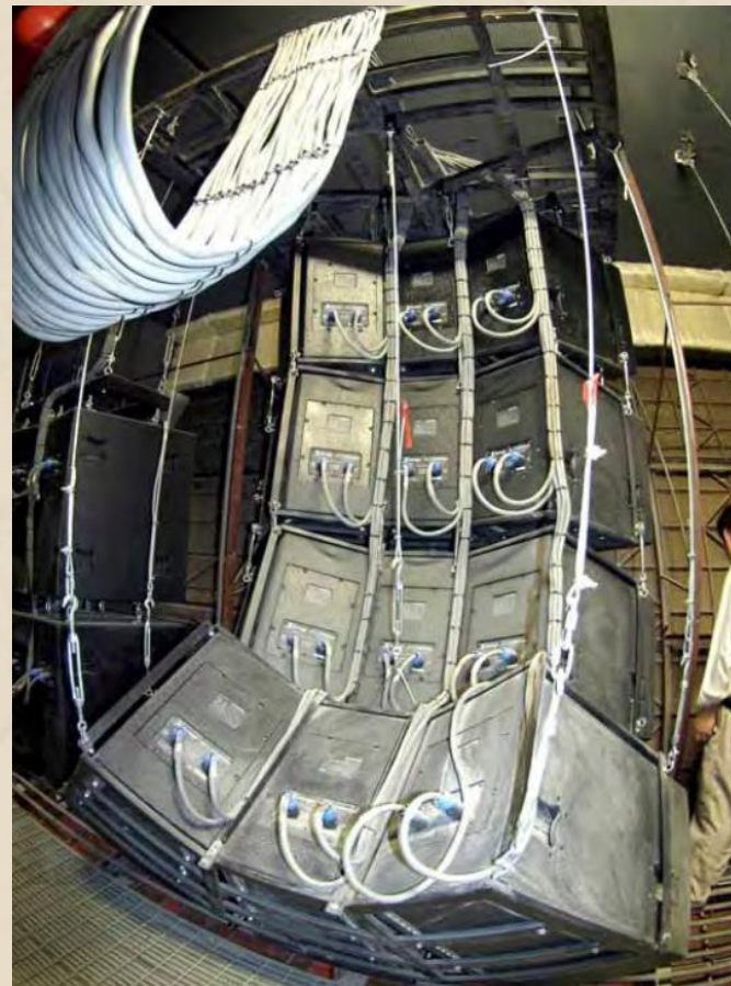
音桥内扬声器组的安装方式、阵列音箱，非线阵
