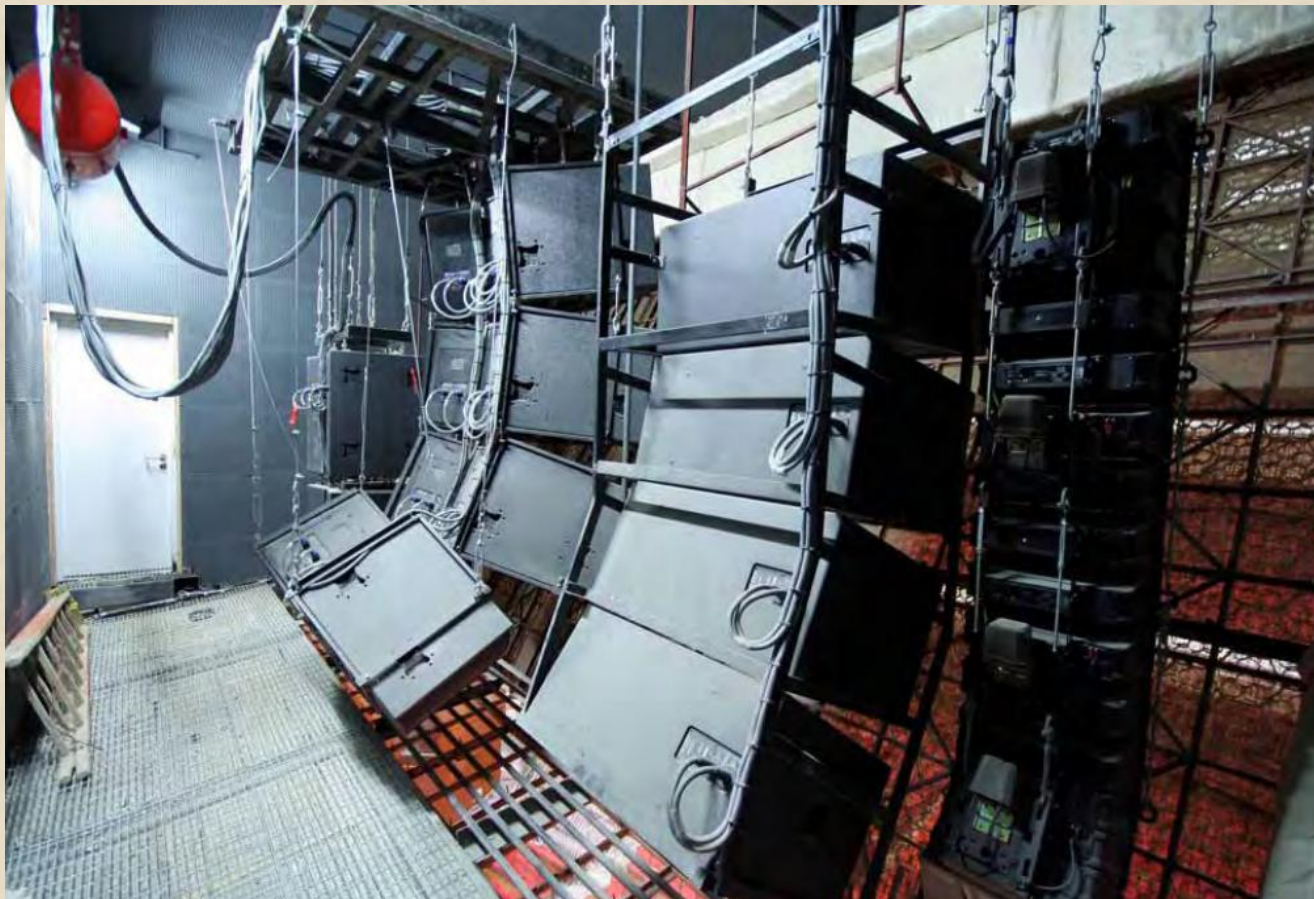
音桥内扬声器组的安装方式、阵列音箱，非线阵
