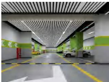
公安局大楼地下车库
