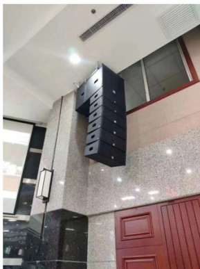
线阵音箱吊装
