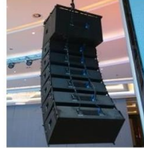
连接方式：全频音箱是手拉手的连接方式
