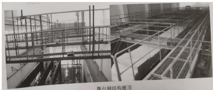
舞台钢结构栅顶
